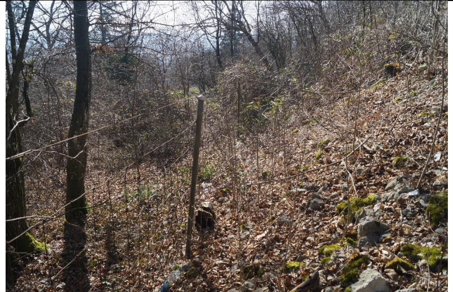
... am Ende einer steilen Böschung angrenzend an einen Waldstreifen (Zaun wird demnächst ersetzt!)
