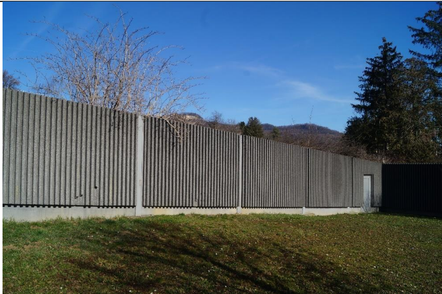
Massive 3 m hohe Wand umgibt den östlichen Teil des Rastplatzes
