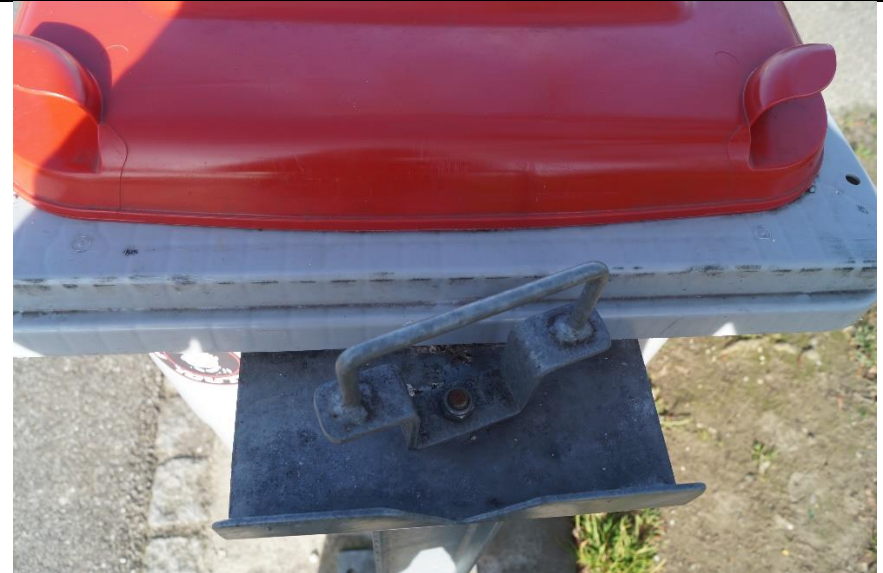
Nicht korrekt betätigte Fixierung des Mülleimers
