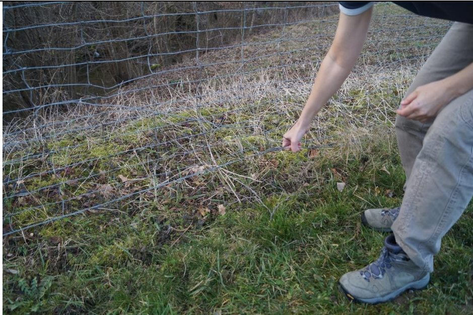
Aufgrund mangelnder Drahtspannung durch Zug oder Druck anhebbarer Zaun
