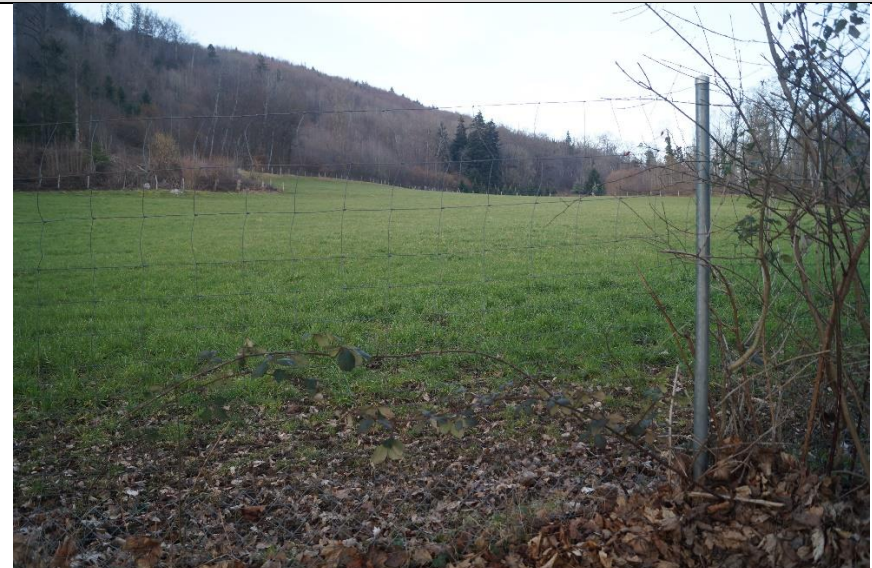
1.6 m hoher Knotengitterzaun mit nach unten enger werdender Maschenweite im Picknickareal
