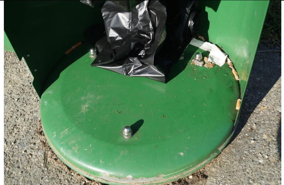
Der Mülleimer ist lediglich mit 3 Schrauben in den Grund fixiert und daher nur bedingt standfest
