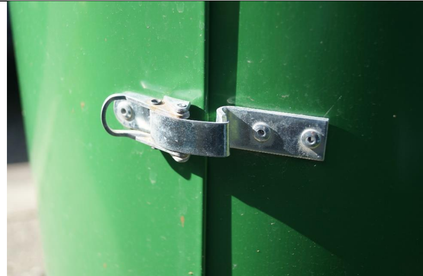
Mechanismus muss sehr gezielt betätigt werden und ist dennoch nur unbefriedigend verschlossen, da die Mülleimertüre bei nur leichtem Stoss sofort aufspringt
