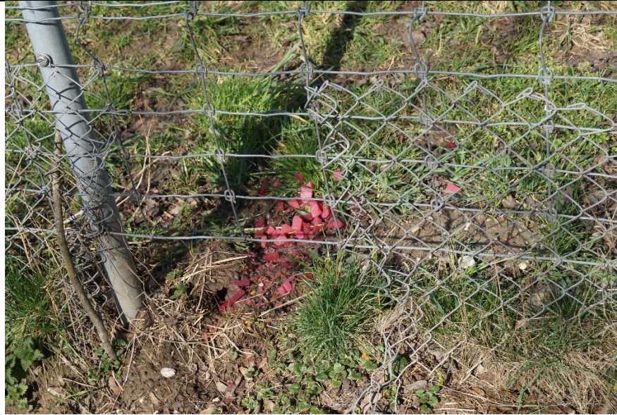
Lebensmittelreste an einer Stelle, an der ein Stück des 5 x 5 cm-Maschendrahts defekt ist
