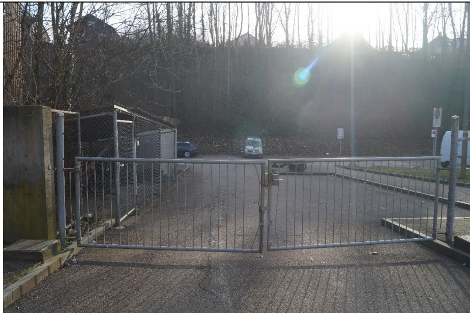
Doppeltüriges Zauntor mit grösseren Abständen zwischen Zaun und Boden, Zaun und Seitenverankerung und teilweise erweitertem Abstand zwischen den Metallstäben
