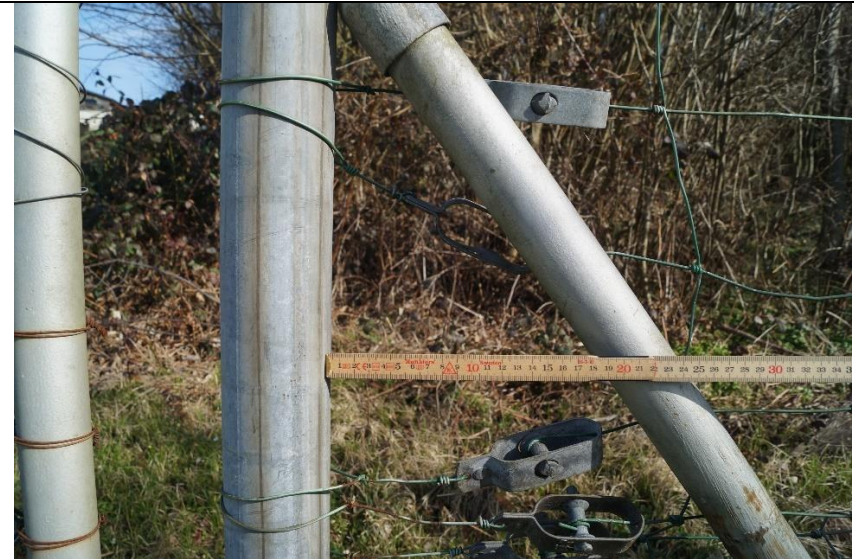
Grössere Abstände und Lücken im Bereich der Zauntüre
