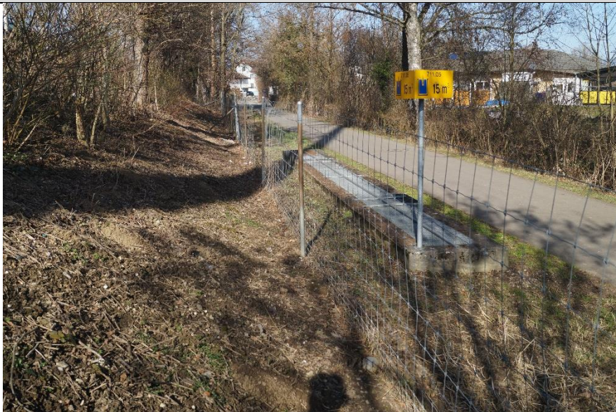
Knotengitterzaun von 1.7 m Höhe und einer Maschenweite von 15 x 20 cm im oberen Bereich
