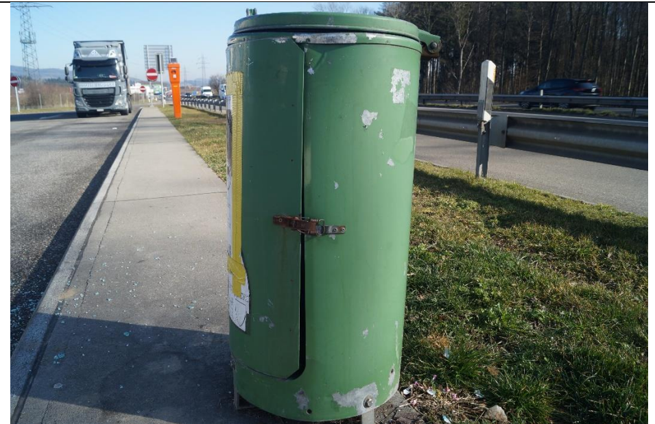
Klaffende Mülleimerseite mit rostigem Verschlussmechanismus
