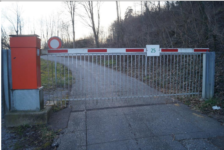
Barriere mit einigen Lücken und Schwachstellen...
