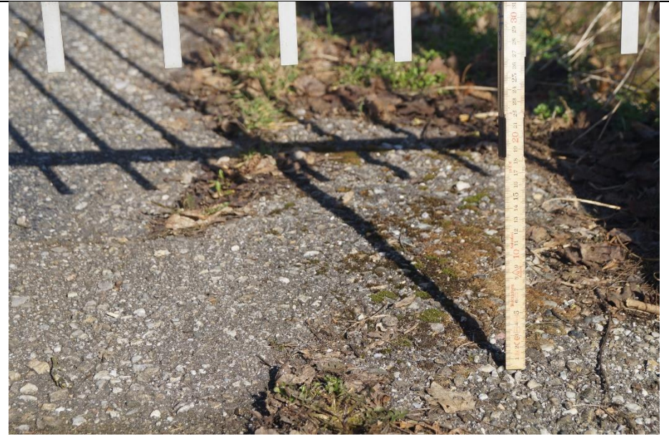
Es bleibt ein 27 cm breiter Abstand zwischen Barriere und Boden, der sich durch Druck erweitern lässt
