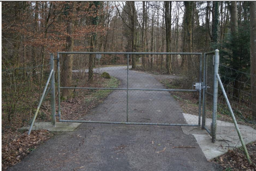
Einwandfrei verschlossenes Zauntor
