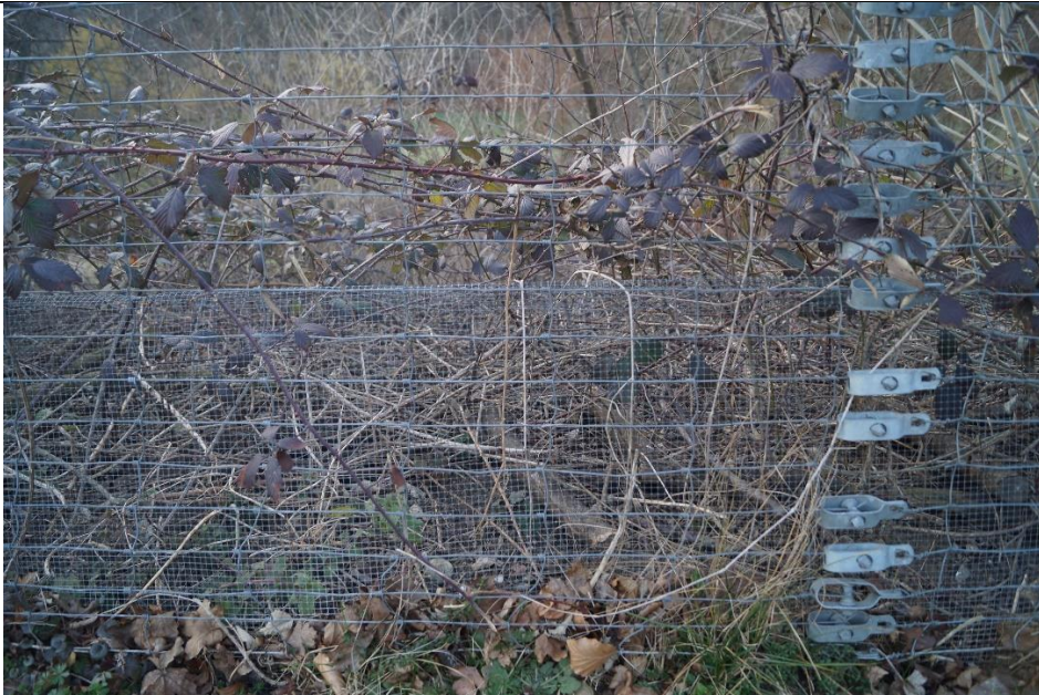
Nach unten engmaschiger werdender Knotengitterzaun – zu unterst 8 mm x 8 mm Maschen
