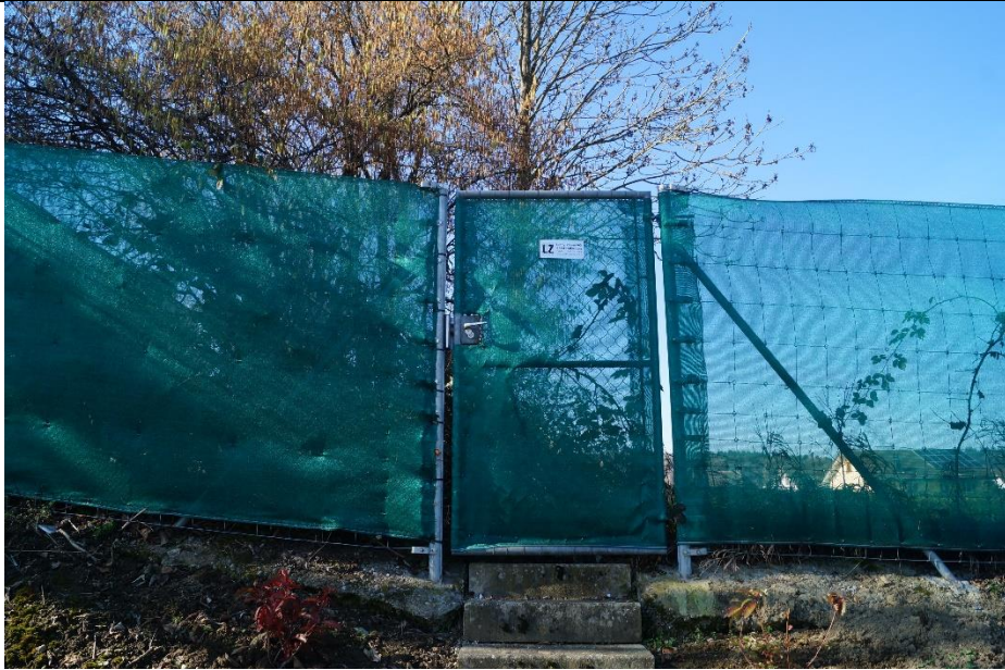
Verschliessbare Zauntüre mit zusätzlichem Sichtschutz...
