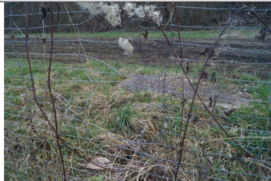
Zahlreiche Defekte im Drahtgeflecht
