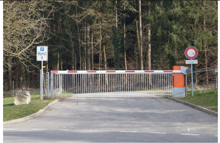
Barriere mit gutem Bodenschluss
