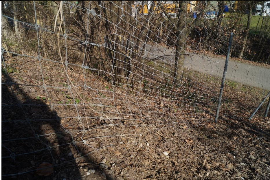
Zaun mit fehlender Drahtspannung und daher schlaffer Aufhängung
