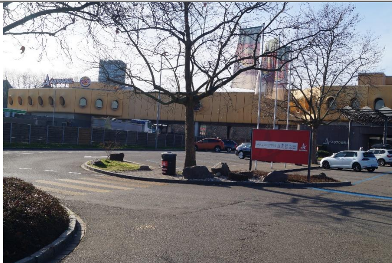
Die über eine Geschäftsbrücke verbundenen Raststätten Pratteln Nord und Süd mit weitläufigem Parkplatz- und Picknickareal
