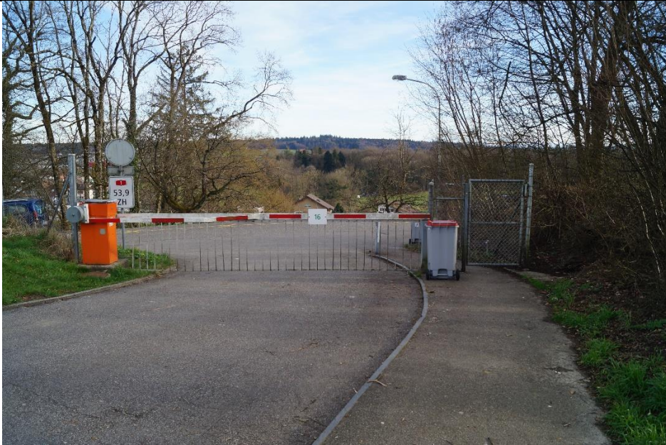
Barriere mit Schwenktüre für den Zugang von Süden her
