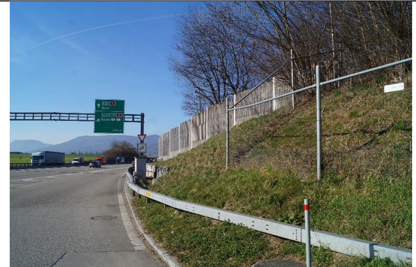
Knotengitterzaun mit anschliessender massiver Wand bei der Raststättenausfahrt
