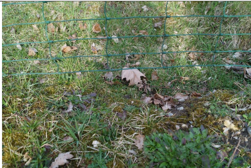
Fehlender Bodenschluss in Bodenvertiefungen (rechts der Zauntüre)
