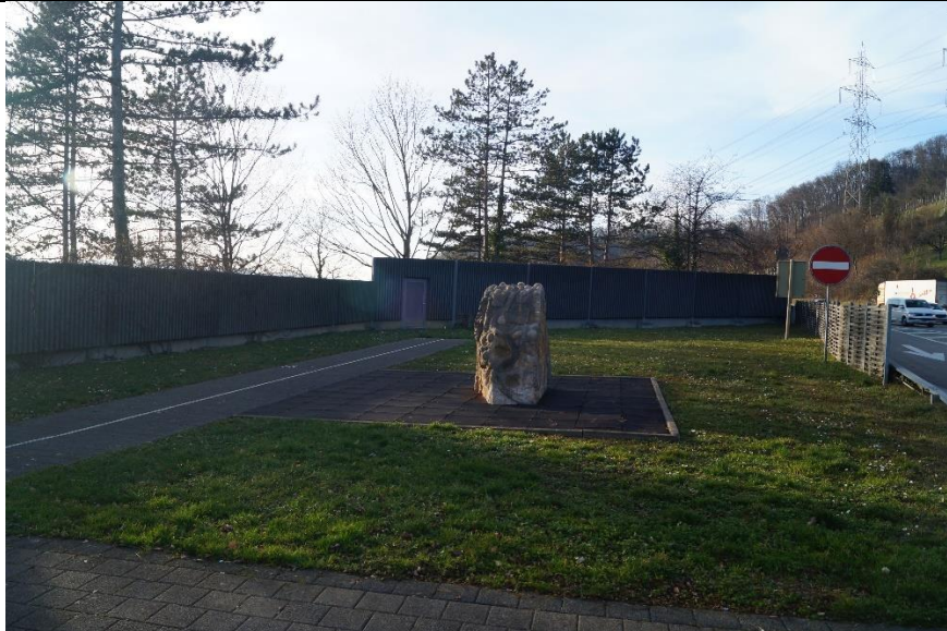
Massive, bis zu 2.1 m hohe Wand als Umzäunung des Rastplatzes
