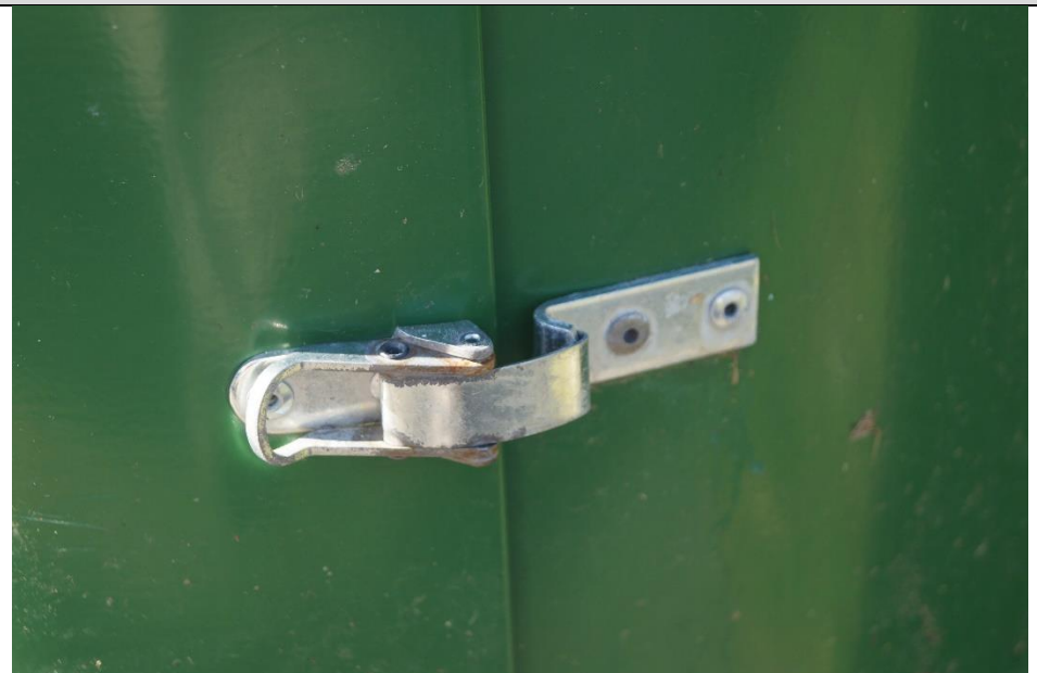
Mülleimer wird nur über diesen leicht zu bedienenden Verschliessmechanismus für Leerungen geöffnet
