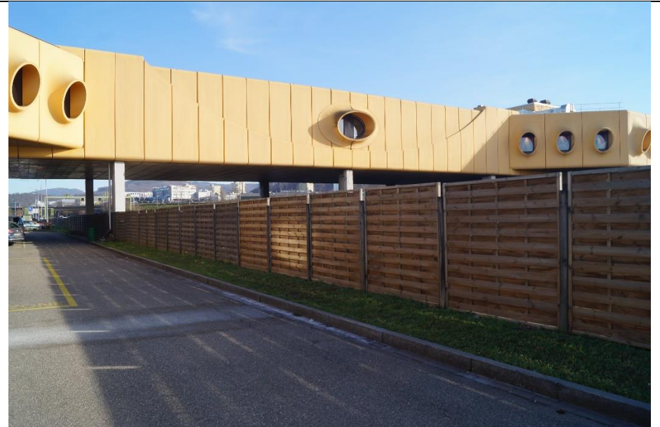
Hölzerne Sicht- und Hörschutzwand zur dreispurigen Autobahn hin
