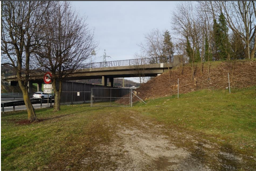
Nur Richtung Osten wird das Areal durch einen Knotengitterzaun begrenzt (der grösste Teil des Areals ist durch eine ca. 3 m hohe massive Schallschutzwand umgeben)
