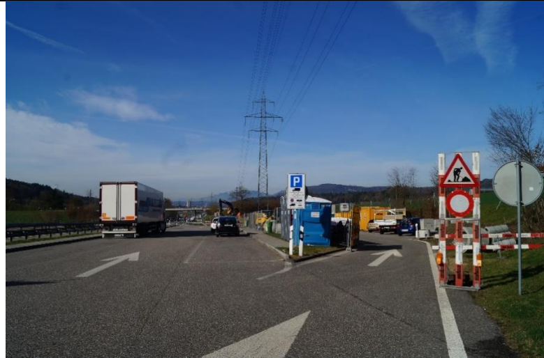
Rastplatz derzeit aufgrund mehrerer Bauetappen partiell gesperrt
