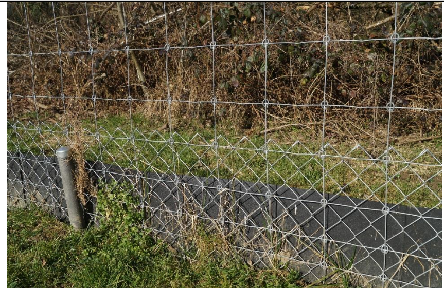
Zaun mit teilweise zusätzlichem Schutz auf den untersten 45 cm
