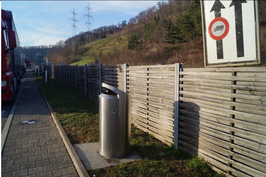
Hohe Anzahl an standfesten «Abfallhai» Mülleimern entlang des LKW-Parkplatzes
