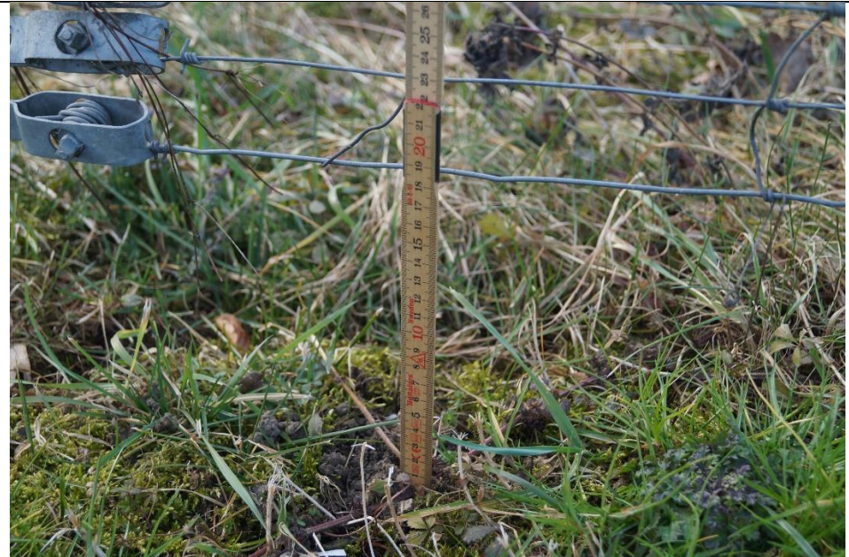
Fehlender Bodenschluss mit 19 cm Abstand zum Grund
