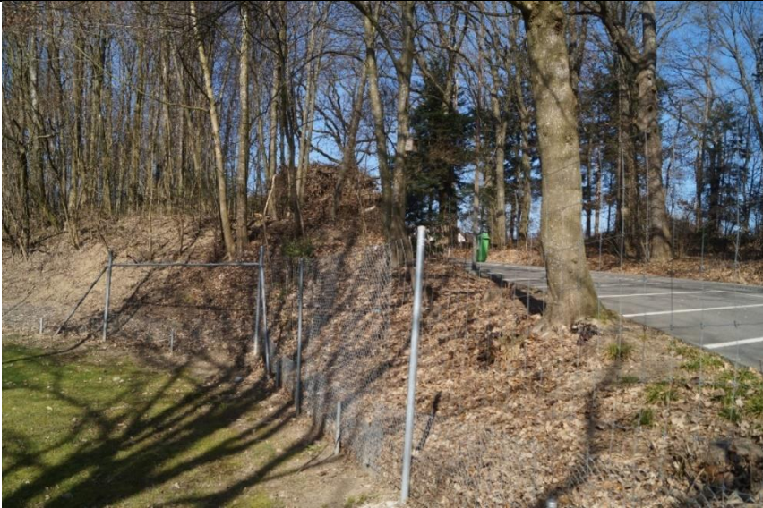
Zaun grenznah zu einem kleinen Wald mit zahlreichen Eichen, im untersten Bereich des Zauns zusätzlich verstärkt mit engmaschigerem Zaun
