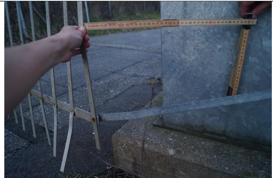
...bei leichtem Zug oder Druck entsteht eine 18 cm breite Lücke zwischen Barriere und Verankerung
