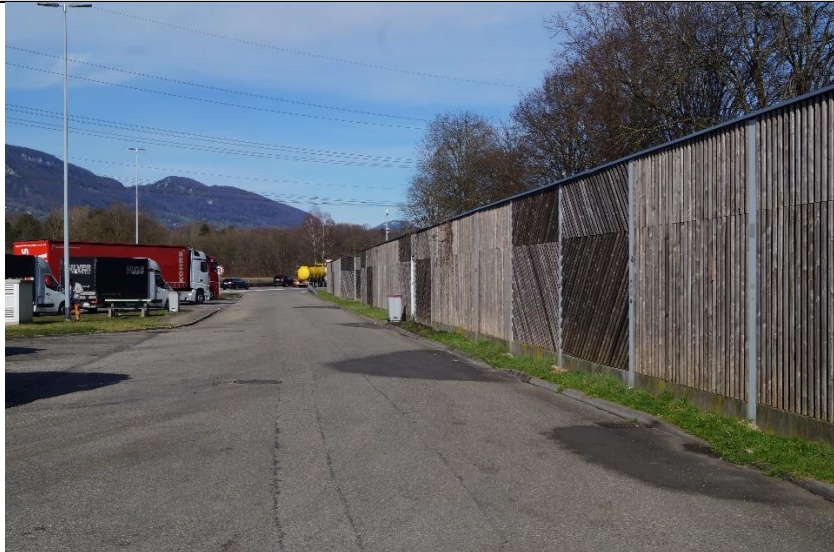
Massive, ca. 3 m hohe Schallschutzwand auf fast dem gesamten Raststättenareal
