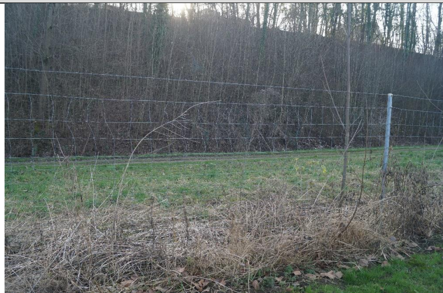
1.8 m hoher Knotengitterzaun mit nach unten enger werdender Maschenweite, zu oberst mit Stacheldraht
