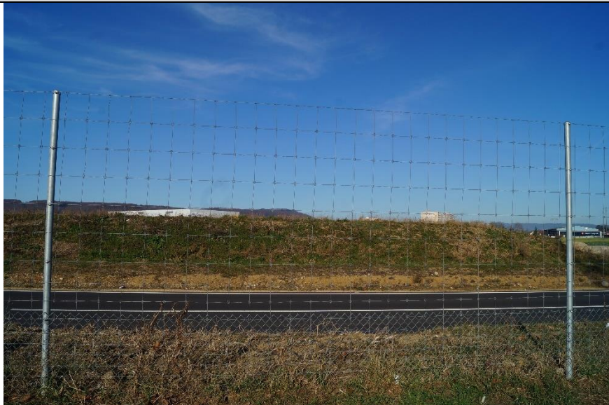
Relativ neu wirkender 2.15 m hoher Knotengitterzaun mit nach unten abnehmender Maschenweite
