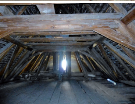
Kirche vor der Sanierung
