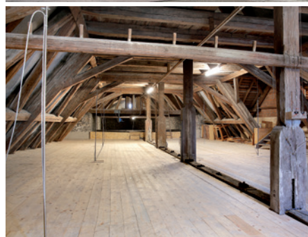
Kirche nach der Sanierung
