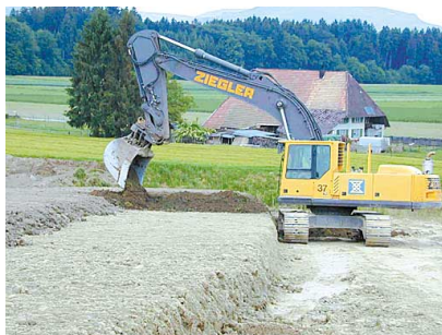
Bagger beim Rekultivieren: Auftragen des Oberbodens auf den Unterboden
