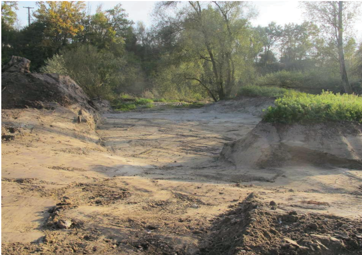
Knöterichaushub im Sandboden
