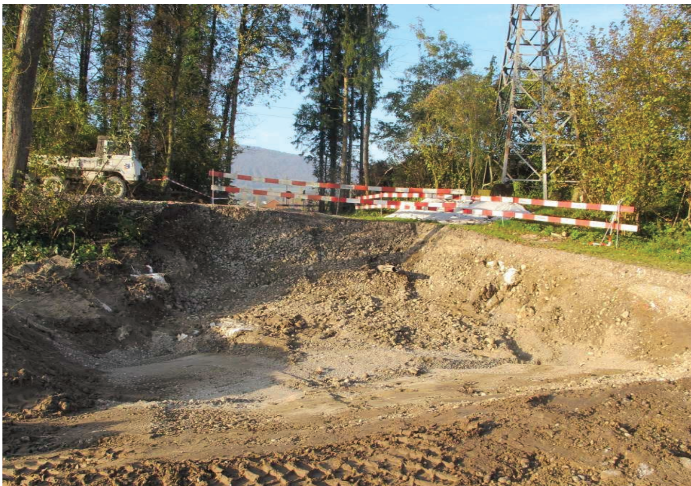
Knöterichaushub in Kiesboden
