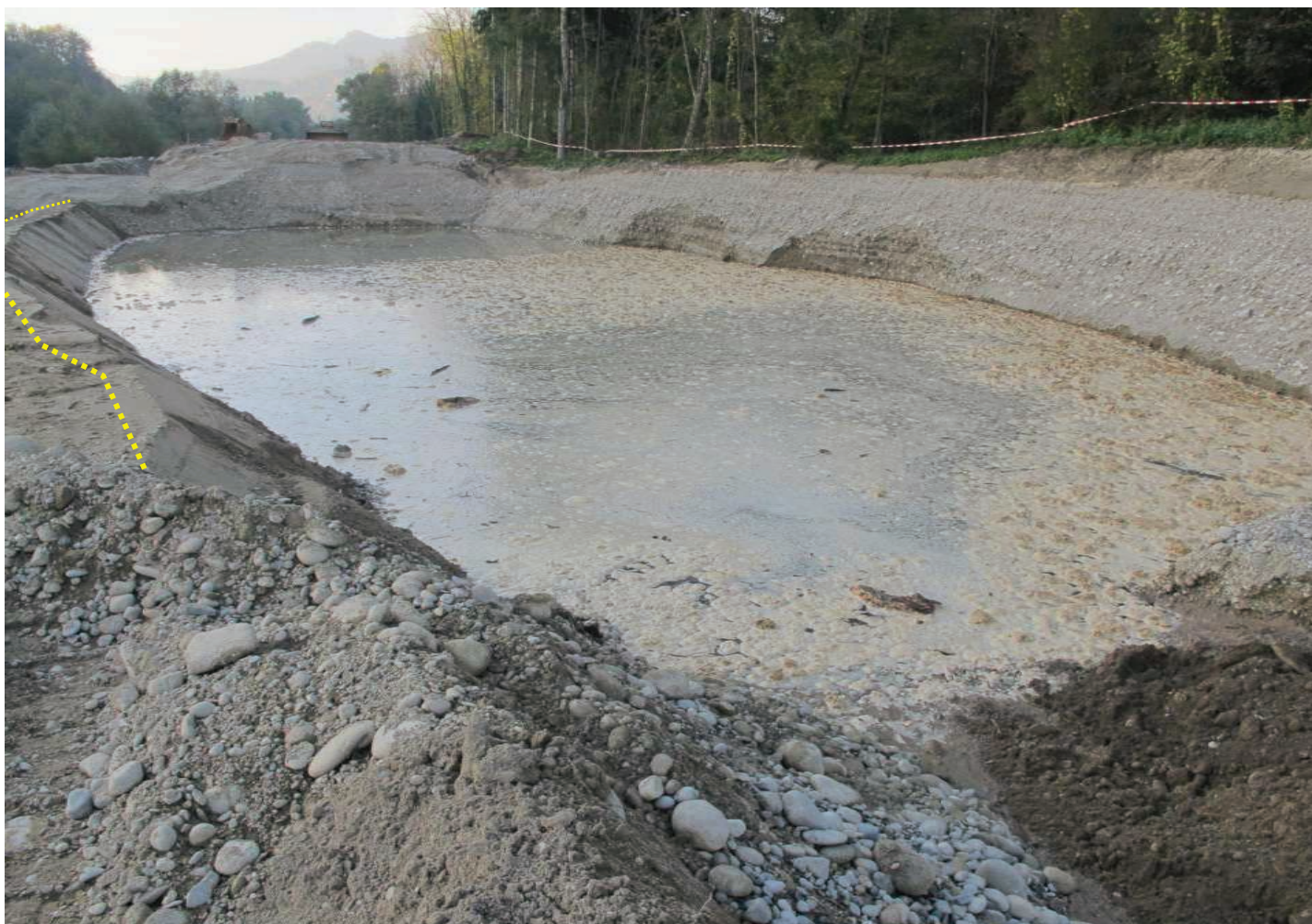
Verlangsamter Einbau im letzten Becken im Hinblick auf langsamen Ausgleich des örtlichen Grundwasserstandes
