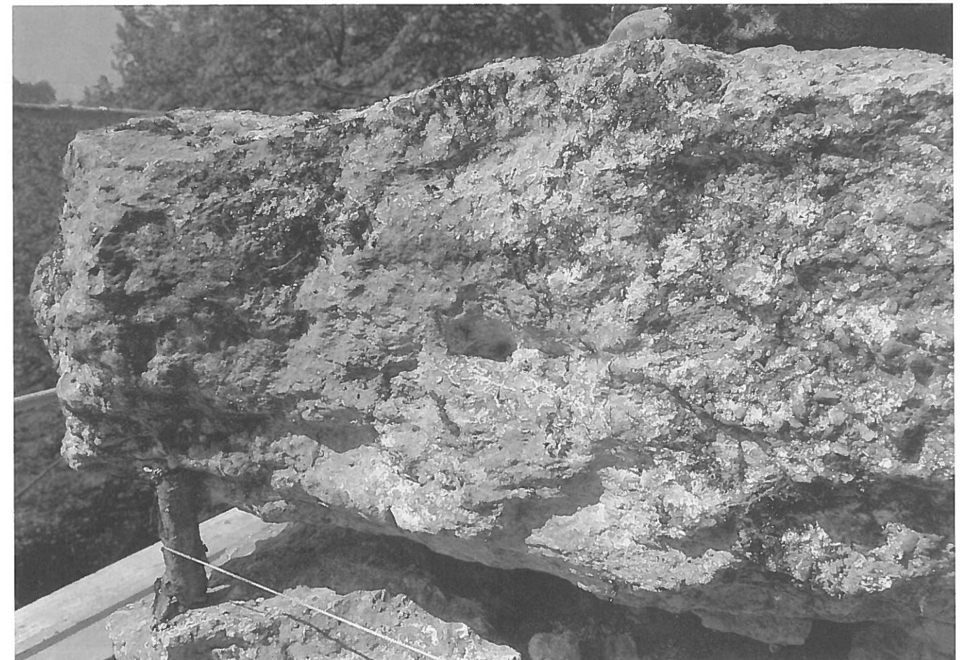
Der rund 110×30 cm mächtige Block zeigt ein konisch nach innen zulaufendes Zangeloch. An der Ostwand des Turmes sind im aufgehenden Mauerwerk noch an drei weiteren Blöcken ähnlicher Dimension Zangenlöcher festgestellt worden.
