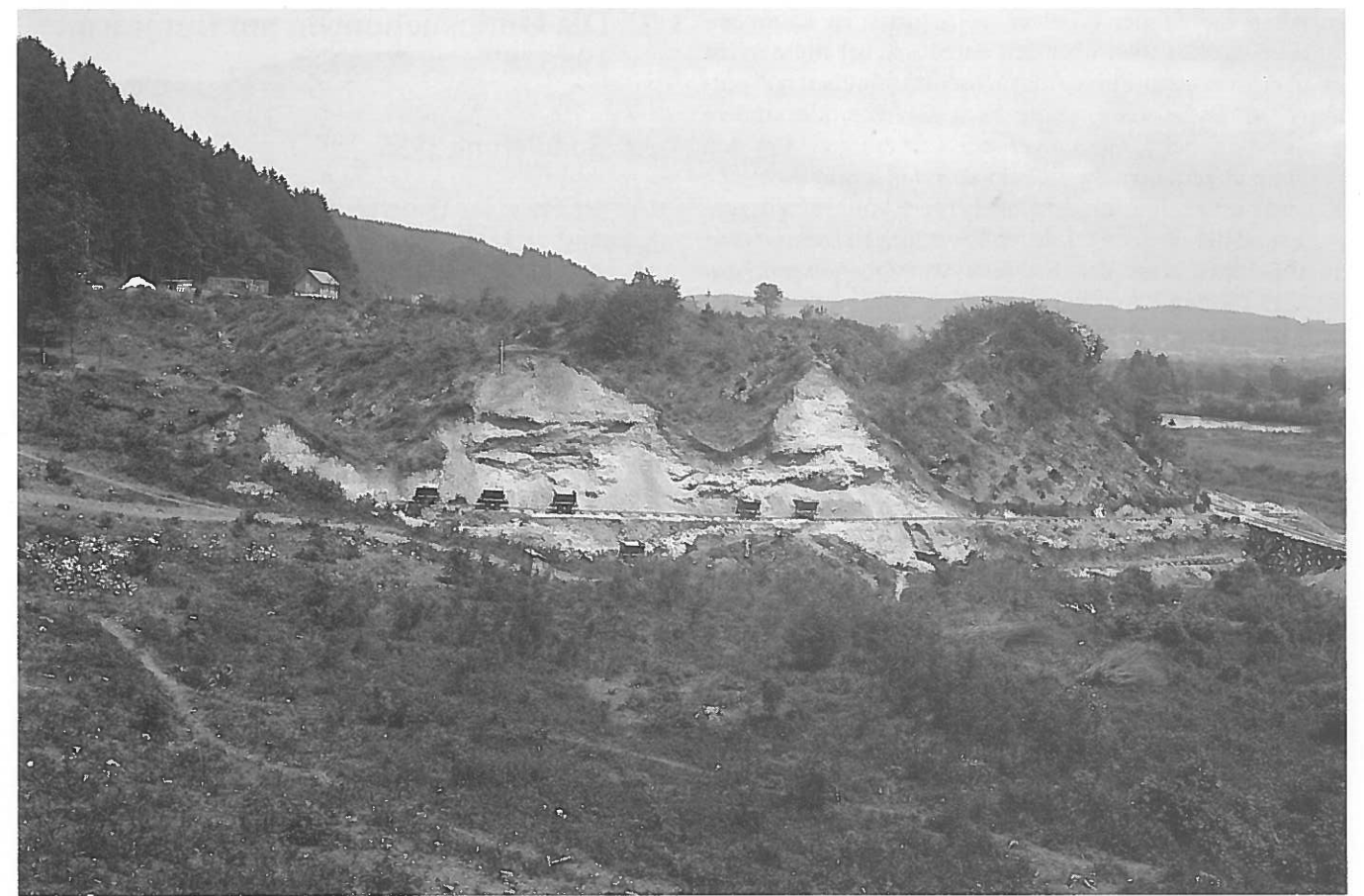
Das Gelände der Burg Obergösgen während den Arbeiten am Kanal 1914. Deutlich erkennbar die beiden angeschnittenen Wälle der Burg. Die Turmruine befindet sich auf dem äussersten rechten Hügel am Rande der Flussniederung (Neg. Kantonsarchäologie Solothurn).
