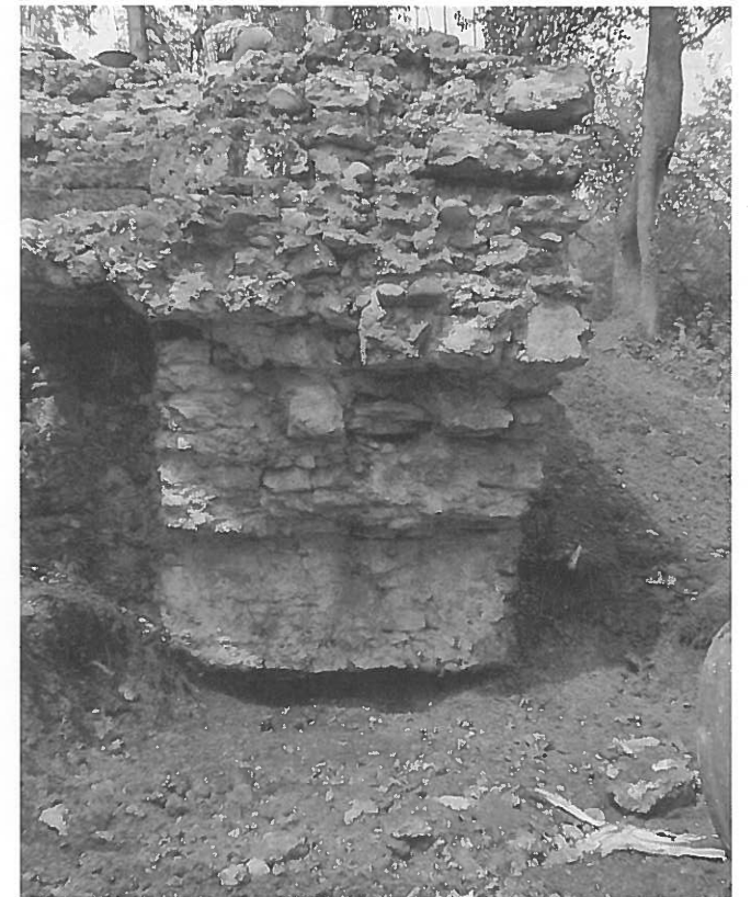
Ansicht der Stirnfläche der östlichen Turmmauer. Die im untersten Teil sichtbare glatte Mauerflucht gehört zur Nordmauer des Turmes. Das Fundament der Ostmauer setzt ca. 1 m höher an.
