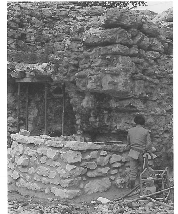
Die überhängenden Partien wurden mit einem mit Bruchstein verkleideten Betonkeil unterfangen. Im Bild der Aufbau der Bruchsteinschale.
