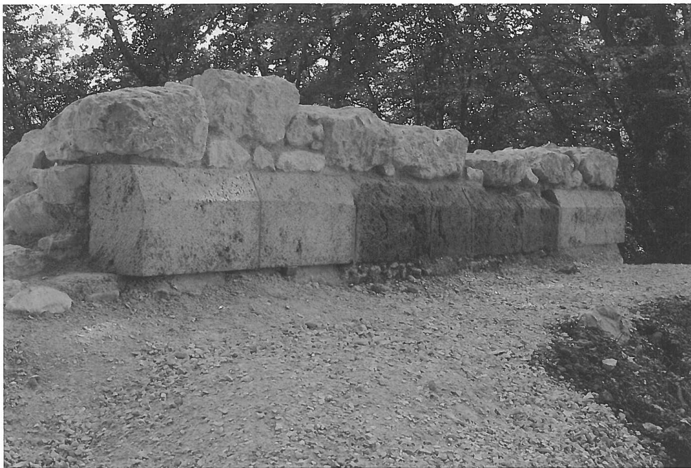
Am Fuss des aufgehenden Turmmauerwerkes war eine Lage gefaster Tuffsteinblöcke angebracht. Die Aufnahme zeigt den rekonstruierten Zustand, in dem die Randpartien (helle Steine) ergänzt wurden.
