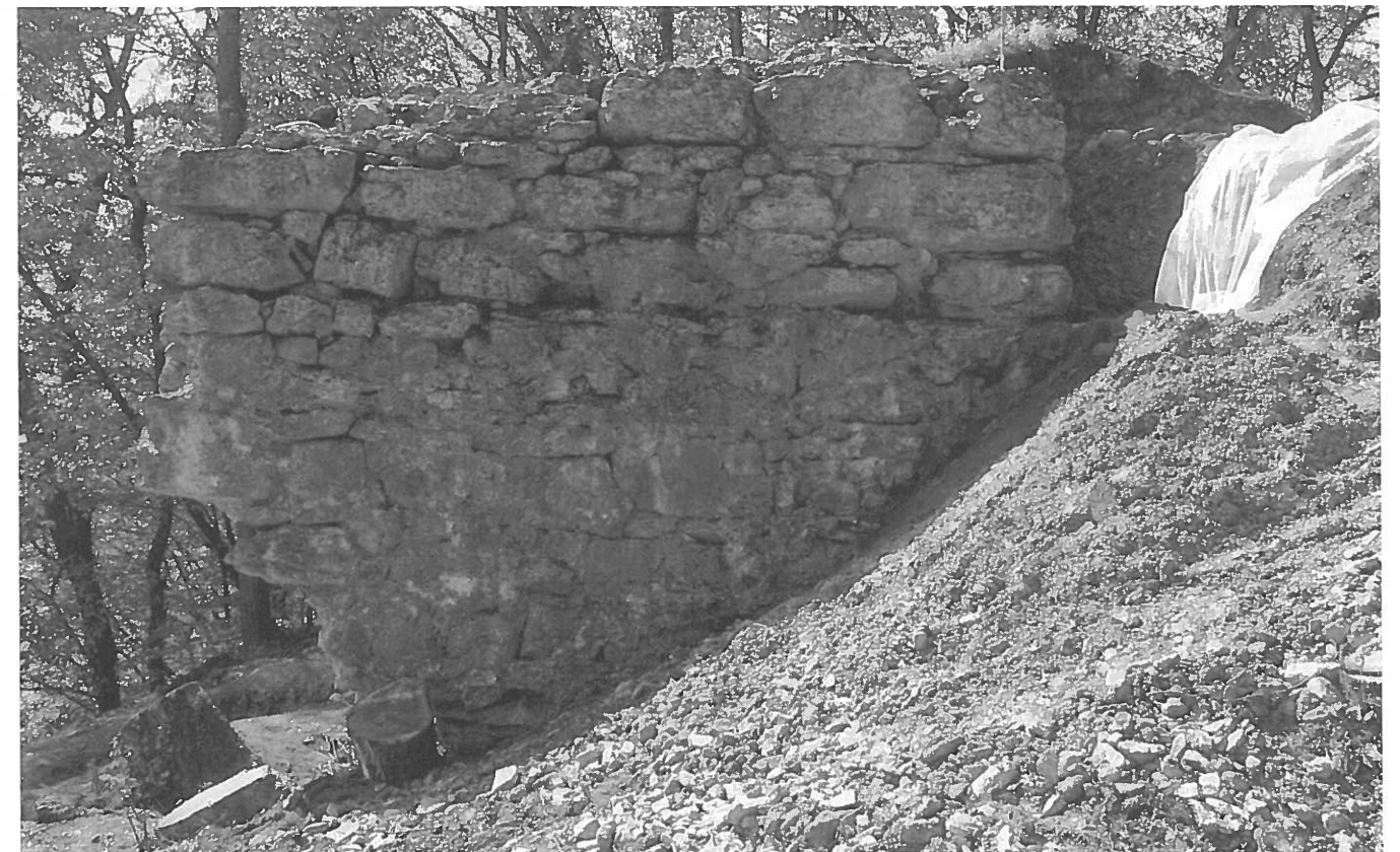
Ansicht der östlichen Turmmauer. Gut erkennbar die horizontale Trennlinie zwischen dem unteren, in Grube gemauerten Turmfundament und dem auf Sicht gemauerten aufgehenden Mauerwerk.
