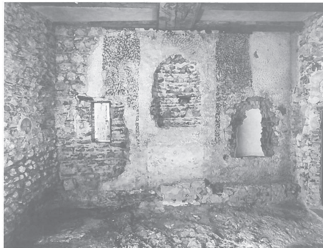
Abb. 31: Kapellen-Südwand mit Negativ des Altars und grün-schwarz gemustertem, auf den Verputz gemaltem Vorhang, der beidseits des Altaraufbaues weitere, nicht mehr genau rekonstruierbare Einbauten berücksichtigt.
