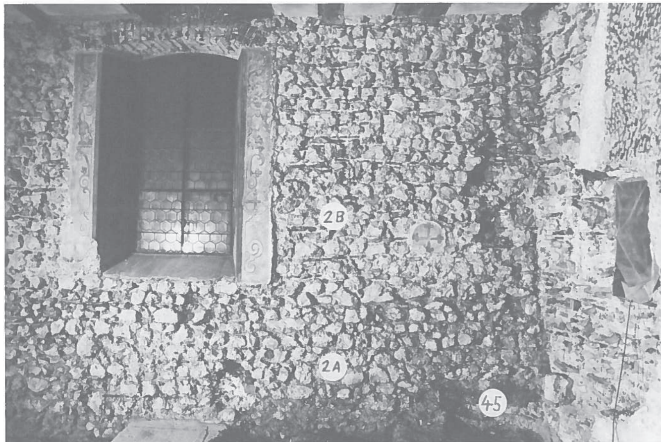
Abb. 21: Südhälfte der Kapellen-Ostmauer: Nr. 45 Fundamentrest vor dem Brand von 1464, Nr. 2 A Umfassungs(?)mauer nach dem Brand, Nr. 2 B Aufmauerung der heutigen Kapelle.
