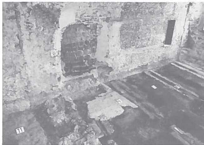
Abb. 26: Nordwand des Kaplaneigebäudes (identisch mit der heutigen Nordwand von Raum 5). Horizontale, in die Mauer eingelassene Hölzer zur Befestigung des ursprünglichen Wandtäfers. Rechts aussen ein originaler Wandkasten, ein weiterer an der Stelle der jüngeren Nische Nr. 12. In der Bodenzone die Unterlage Nr. 4 zu einem Ofen, die Bretterbodenunterlagen Nr. 8 sowie der Verlegemörtel zum Tonplattenboden Nr. 11; Nr. 5 bezeichnet eine Auffüllung aus Brandschuttmaterial.
