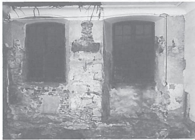
Abb. 23: Ostmauer im heutigen Raum 5: Eichener Fenstersturz aus der Bauzeit der Mauer Nr. 2. Die beiden heutigen Fenster und die Unterfangung des alten Fenstersturzes aus der Bauzeit von 1695 ff.
