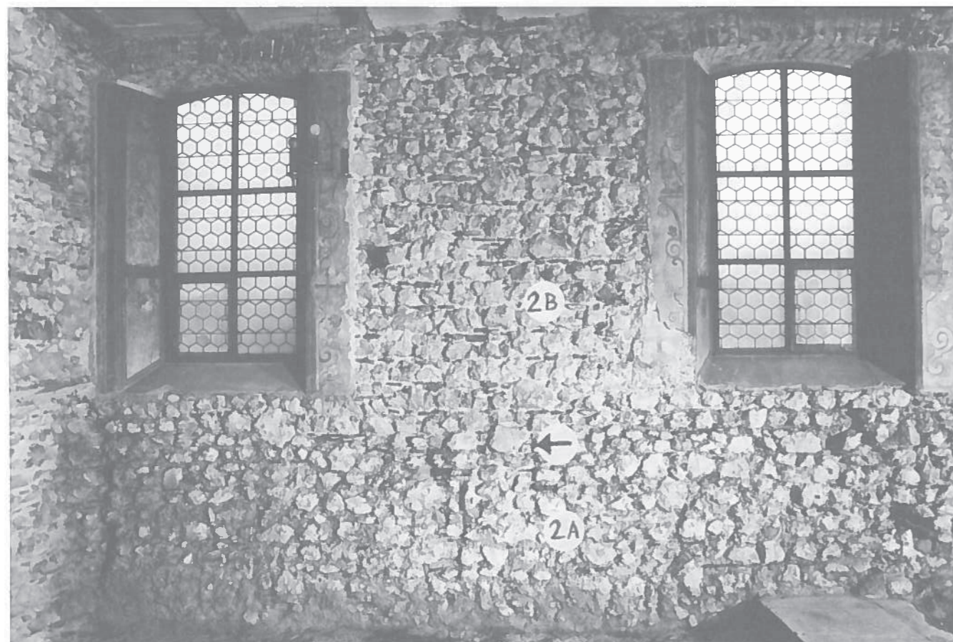
Abb. 22: Nordhälfte der Kapellen-Ostmauer. Der Pfeil verweist auf das vermauerte Fensterchen.
