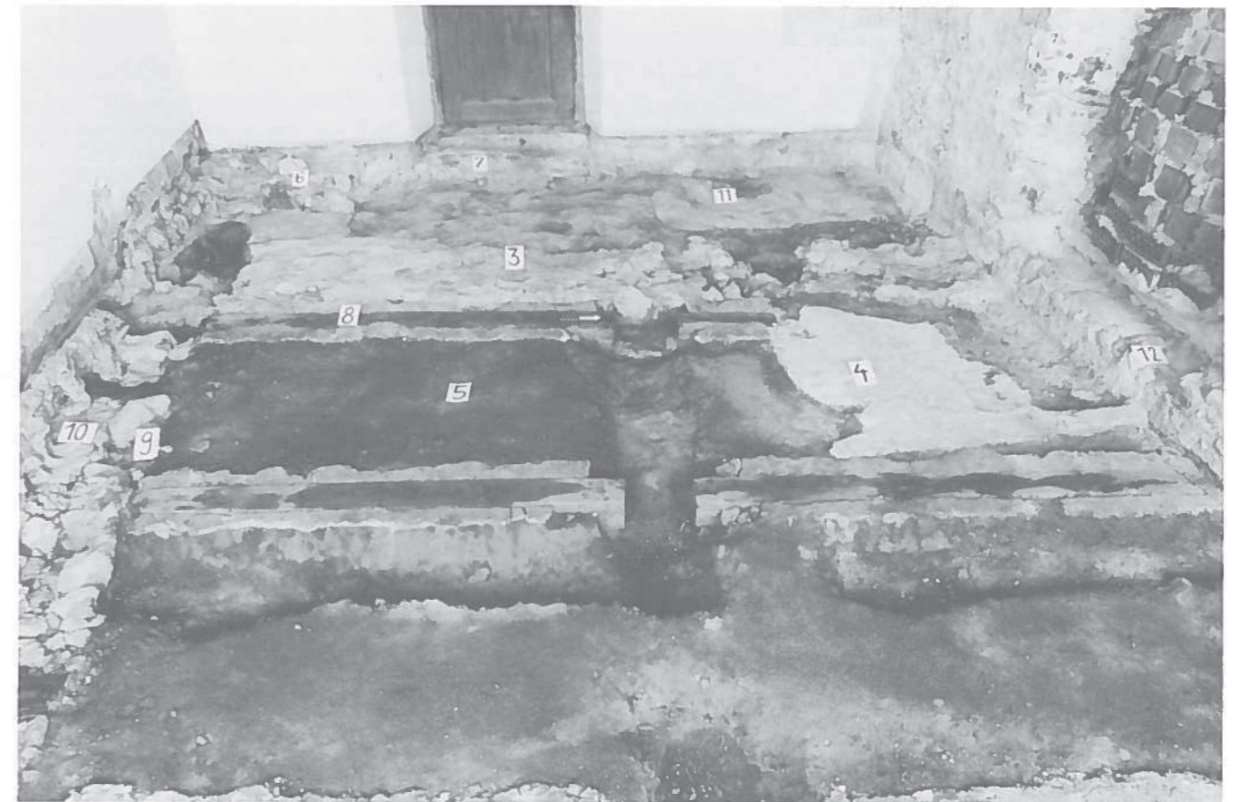
Abb. 34: Raum 5: Blick gegen Westen mit jüngeren Einbauten im Kaplaneigebäude (mit Ausnahme des Ofenfundamentes Nr. 6 und der Trennwand Nr. 7 zum Bestand vor 1695 ff.).
