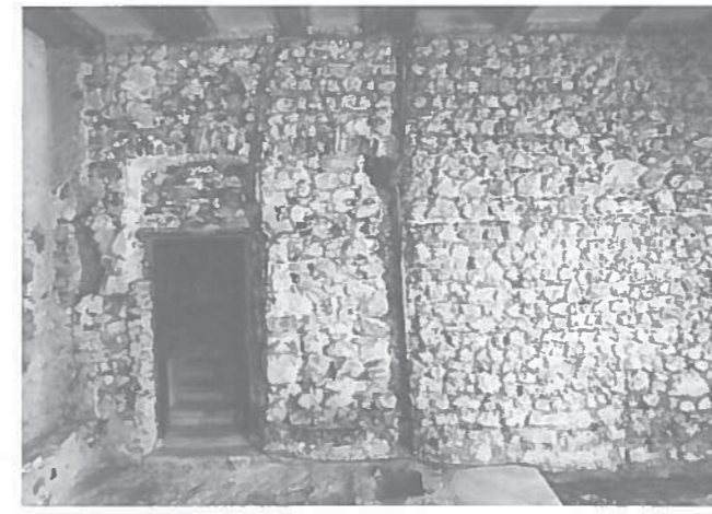
Abb. 24: Südhälfte der Kapellen-Westmauer. Ganz links der ursprüngliche Zugang, daneben der später tiefer gesetzte Eingang von 1695 ff. und rechts die vermauerte Türe, die wohl aus der Zeit des Umbaus von 1647 stammt (sie stört auf der Aussenseite Malereien von 1601).
