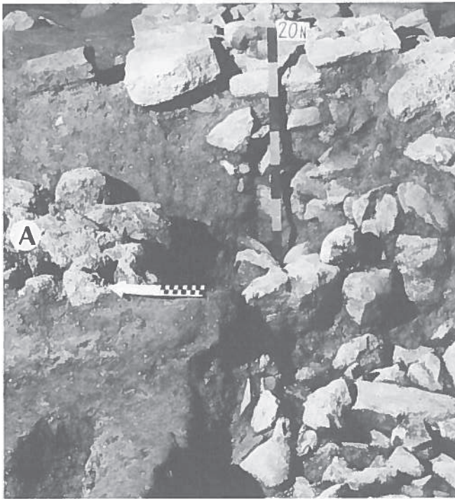
Abb. 18: Schnitt durch die römische Längsmauer Nr. 20 N. Die obersten zwei Steinlagen sind deutlich versetzt auf das Fundament gestellt. A = Grube unbekannter Funktion, gefüllt mit grösseren Mörtelbrocken, die Negative von Holzbrettern zeigen: vertrocknete Reste aus einer mit Holz geschalteten Mörtelgrube.
