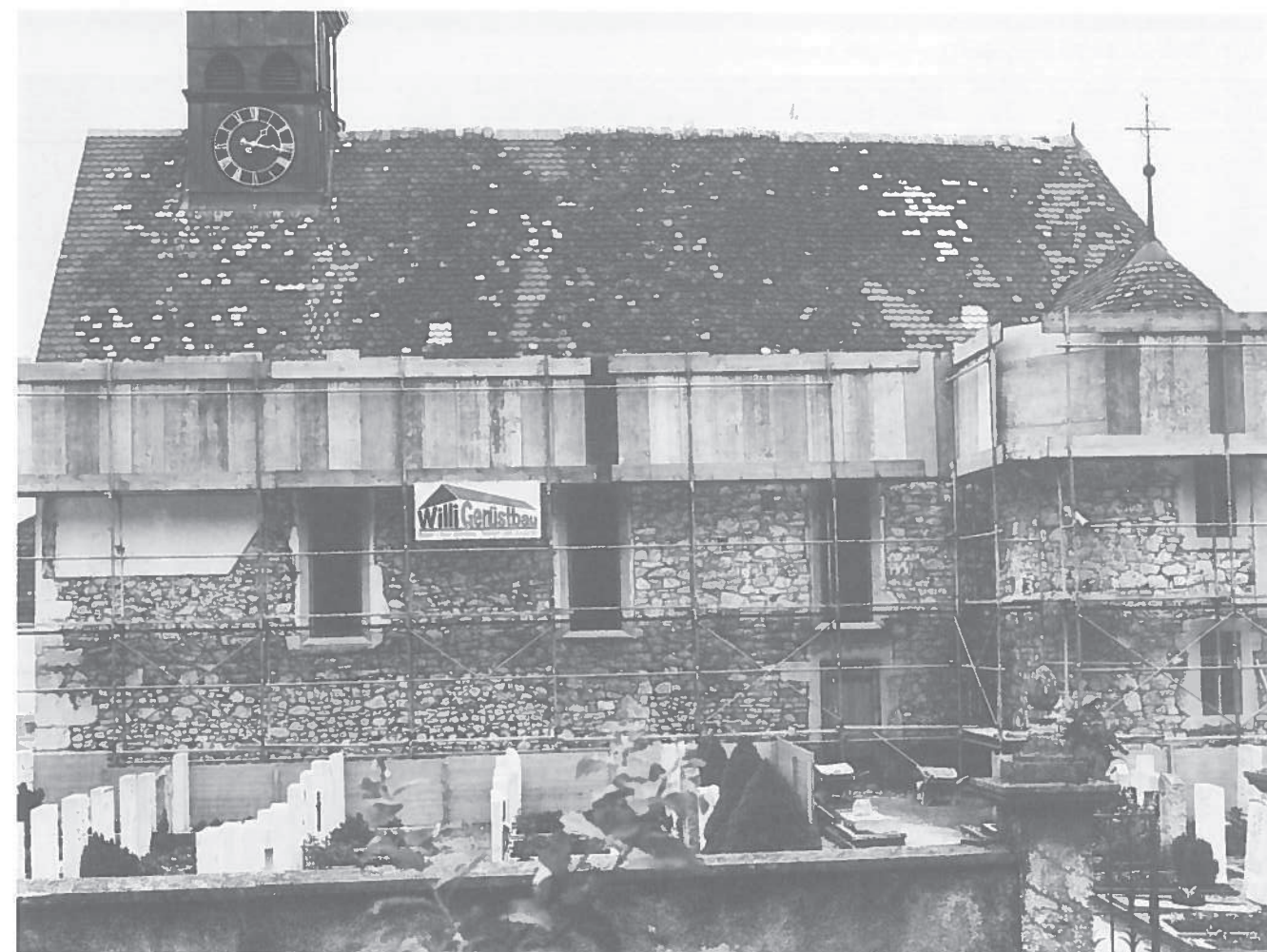
Abb. 4: Ansicht von Süden während der Restaurierung.
