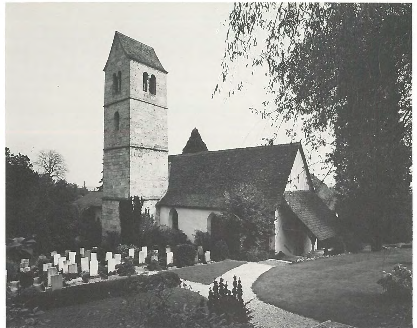
Abb. 1. Ansicht der Kirche von Nordwesten.
