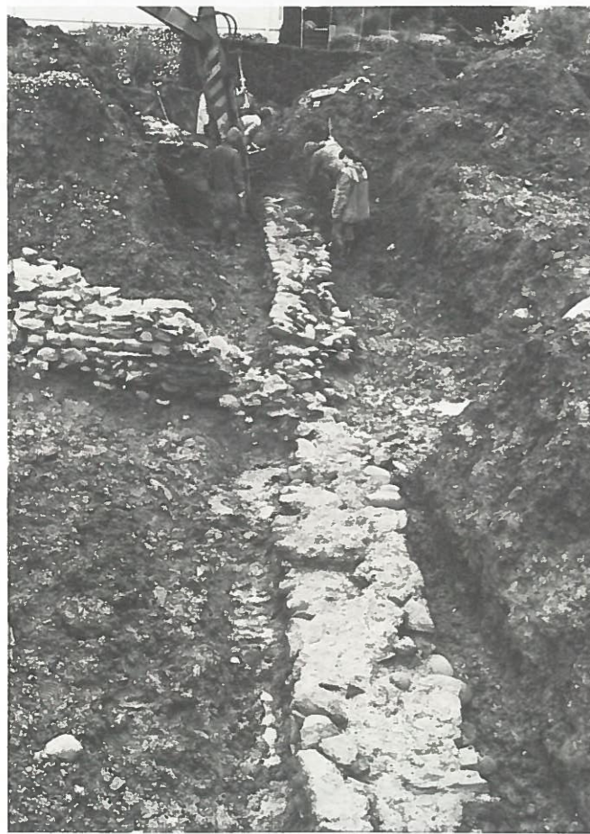
Abb. 10. Parzelle Stuber. Mauerzug 6-7. In der Mitte nach rechts ziehend Mauer 5. Blickrichtung Südwest.
