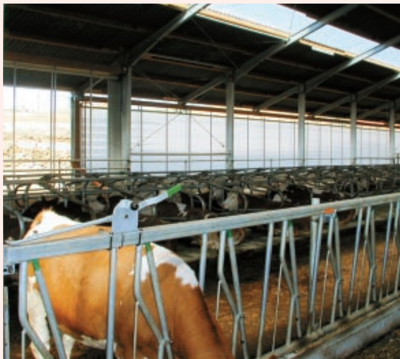
Ställe mit genügender Raumhöhe und offenen, mit Windschutzvorrichtungen versehenen Seitenwänden sind kühler und damit emissionsärmer.
