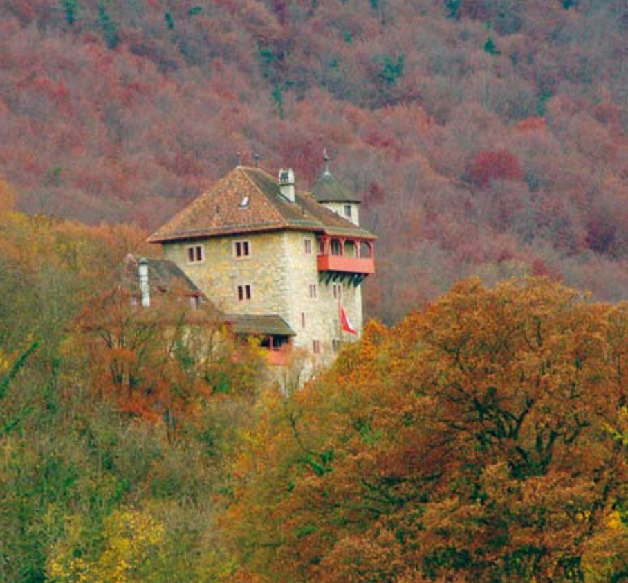
Die Burg Rotberg umgeben von Wald
