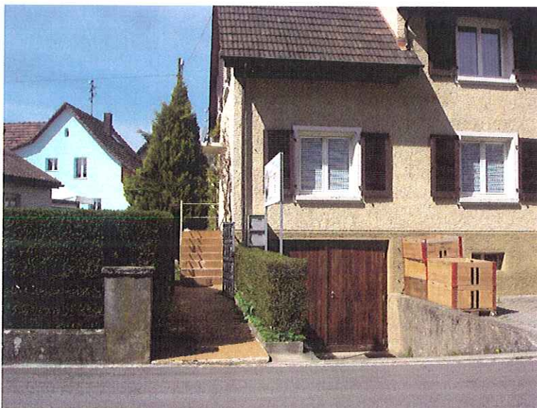
Zugang Haus mit Zufahrtsrampe Garage UG und Parkplatz Ost
