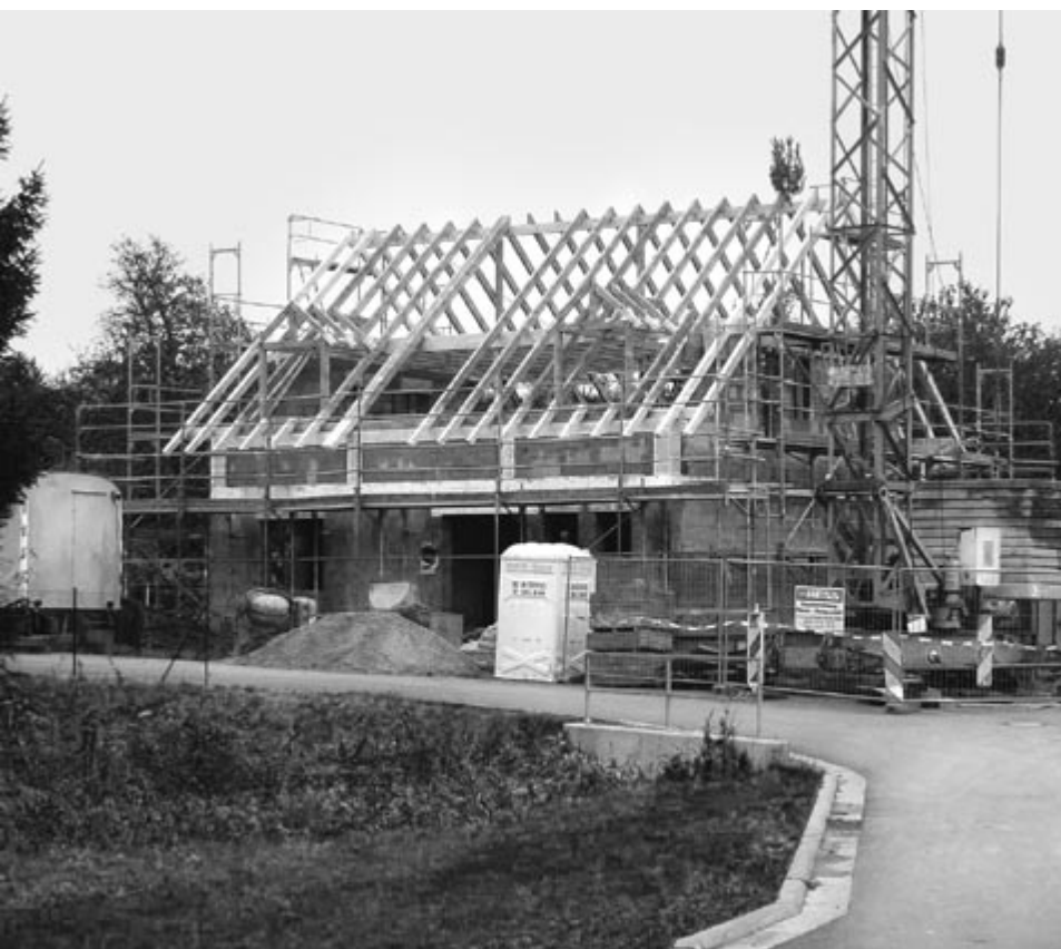
Wer ein Haus baut, beginnt mit Vorteil nicht mit dem Dach.
