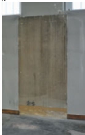
Abb. 19 Im Ausstellungssaal des Untergeschosses blieben Teile der stark kreidenden Leimfarbenmalerei von 1925 erhalten. Aufnahme vor der Festigung.
