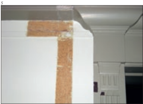
Abb. 5 Farbsondierung in der Eingangshalle. Unter den weissen Farbschichten tritt die ursprüngliche Fassung mit der kleinteiligen Musterung und einem oben verlaufenden Wellenband zutage.
