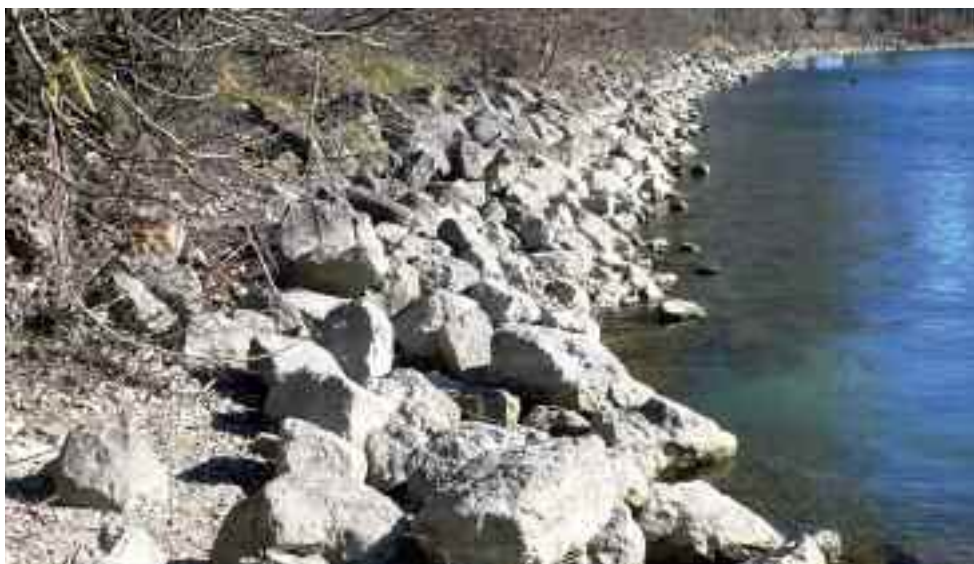
Schmales Steilufer mit Blockwurf an der Aare
